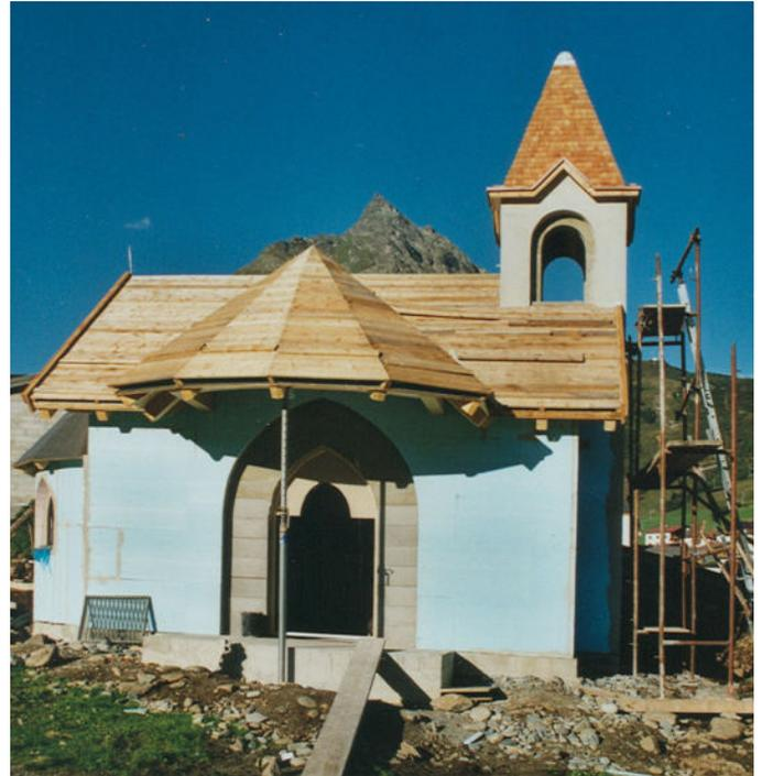
Dachstuhl und Glockenturmhelm wurden von Walter Lenz aus See gezimmert und das Dach mit Schindeln bzw. Schieferplatten von der Firma Gerhard Walser aus Landeck gedeckt. Der Turm wurde nicht wie bei anderen Kapellen einfach auf das Dach gesetzt, sondern als Abschluss der Längsseite vom Boden aufgemauert. Aus diesem Grund wurde die Eingangstür in die Längsseite eingebaut. Die im Turm hängende Glocke stammt aus der bekannten Glockengießerei Grassmayr und wird elektrisch geläutet.
