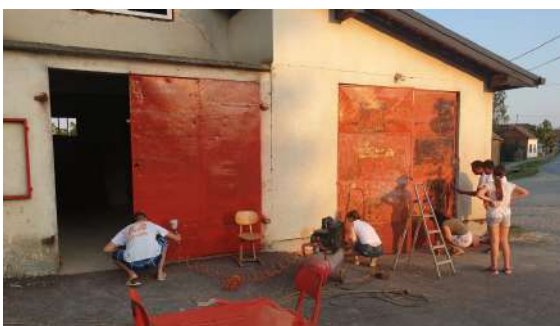
Renovierarbeiten an dem Feuerwehrhaus in Busetina
