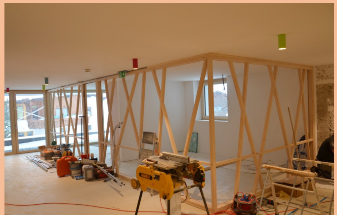
Kindergarten Galtür—die Bautischlerarbeiten in der Endphase
