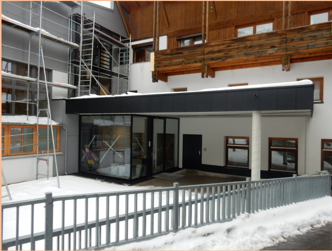
Haupteingang für Schule, Kindergarten und Vereine
